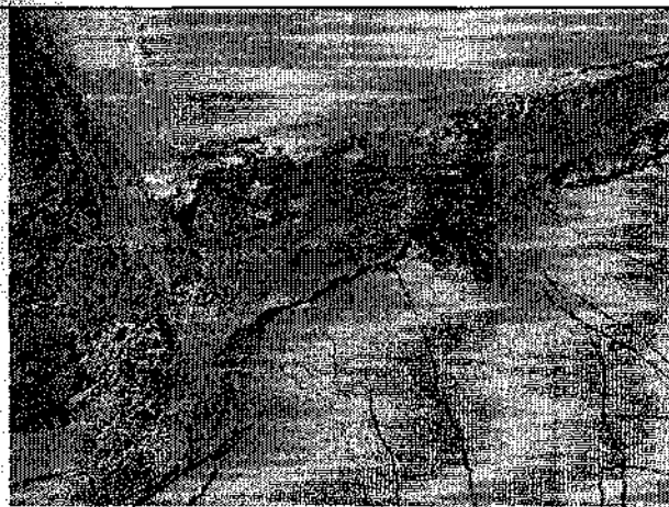
Фото 6, 7. Локальные участки трещин, следов растительности, проседания, неплотного примыкания отливки к цоколю, что способствует замачиванию фундамента здания, а также подвального помещения и не соответствует требованиям п. 6.26 СП 82.13330.2016 «Благоустройство территорий».
