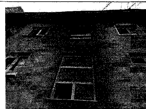
Фото 10, 11. Локальные разрушения защитного штукатурного слоя стены под окнами здания. Дефект эксплуатационного характера. Вызван промерзанием насыщенной влагой кладки и дальнейшим её разрушением, а также внешними
